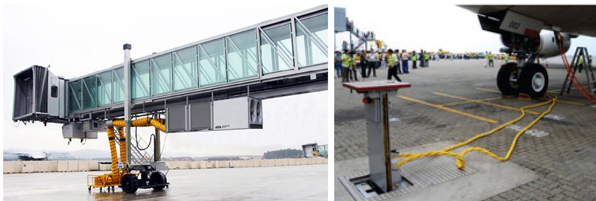
Рис. 2. Аэродромный кондиционер фирмы AXA Power стационарного подвешенного типа (слева) и аэродромная ПИТ система компании CAVOTEC (справа)
